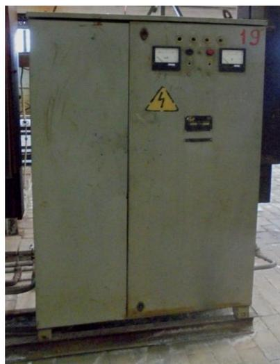
Рисунок 1.10 – Внешний вид тиристорного выпрямителя серии ТВ1
