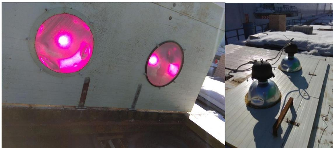
Рисунок 4.12 - Светодиодное освещение первичного отстойника
