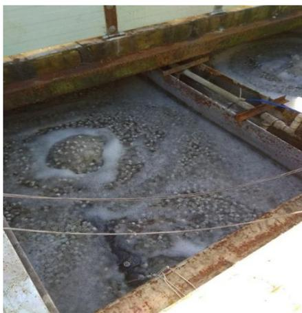
Рисунок 4.11 - Первичный отстойник с плавающей загрузкой
