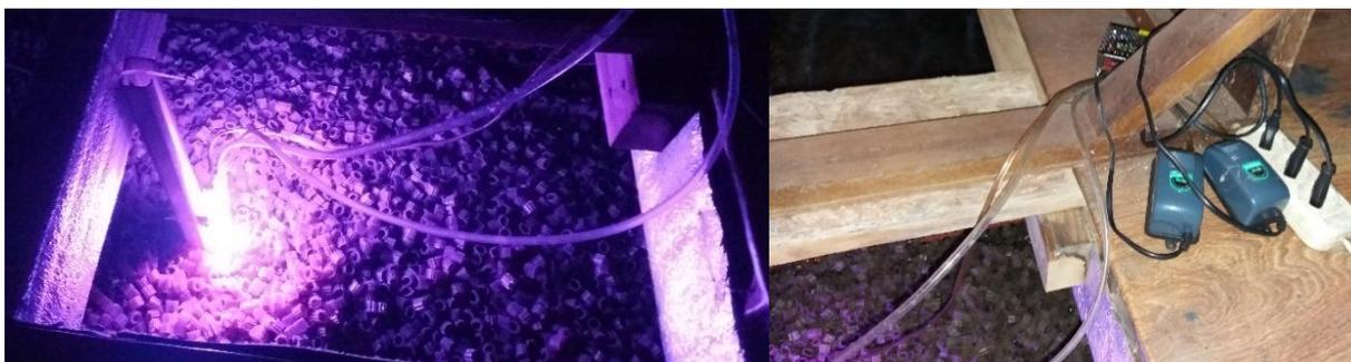
Рисунок 4.5 - Фильтр биологической очистки вод рыбоводческой фермы с носителями биомассы и установленной аэрационно-осветительной установкой
