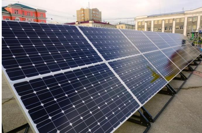
Рисунок 3.1 - Солнечная батарея с модулями из монокристаллического кремния.
