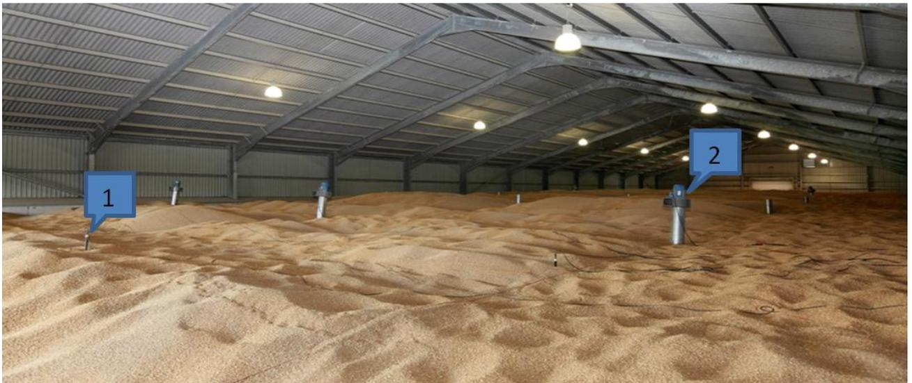
1 – вентиляционные установки; 2 – датчики контроля температуры зерна
