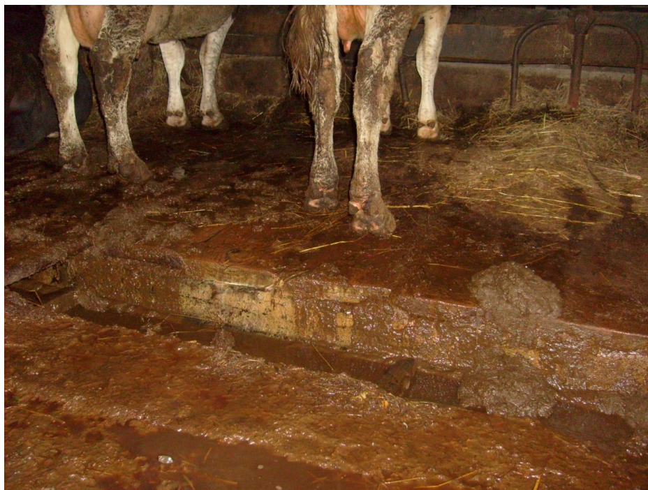
Рисунок 1.7 – Заполнение навозоуборочного канала в коровнике
