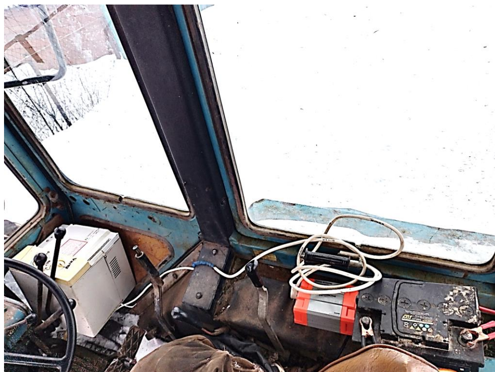
Рисунок 5.14 – Соединение инвертора с аккумулятором трактора МТЗ-80
