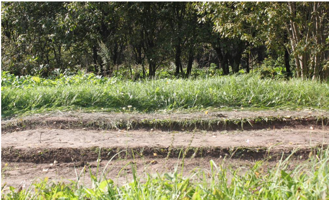
Рисунок 3.19 – Испытательный участок с выбоинами, глубокой колеей и неровностями грунта
