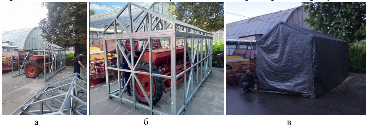
а – сборка каркаса устройства из модульных конструкций; б – каркас устройства в сборе; в – общий вид устройства (наружный слой многослойной ограждающей конструкции устройства – тарпаулин плотностью 120 г/м 2 ).
