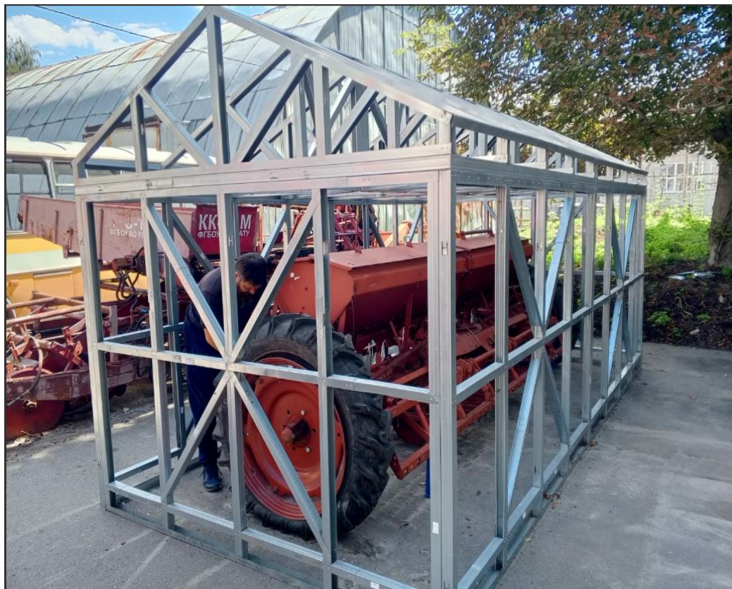
Рисунок 3.14 – Каркас теплового устройства хранения техники
