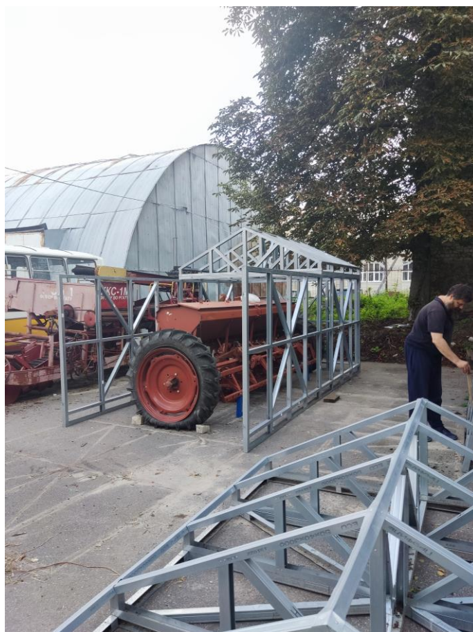
Рисунок 4.15 – Сборка модульного теплового устройства хранения техники
