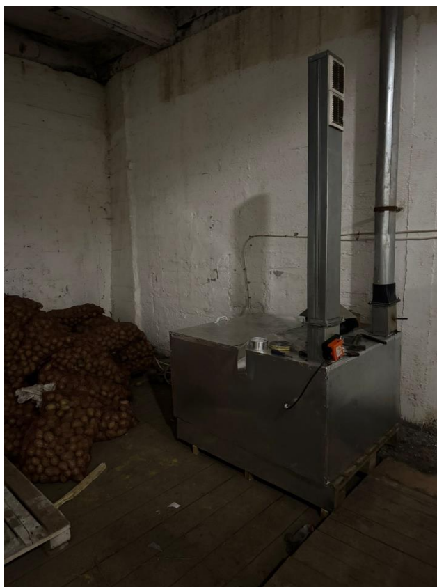
Рисунок 3.3 – Процесс установки и подключения камеры подготовки воздуха для хранения картофеля усовершенствованным способом
