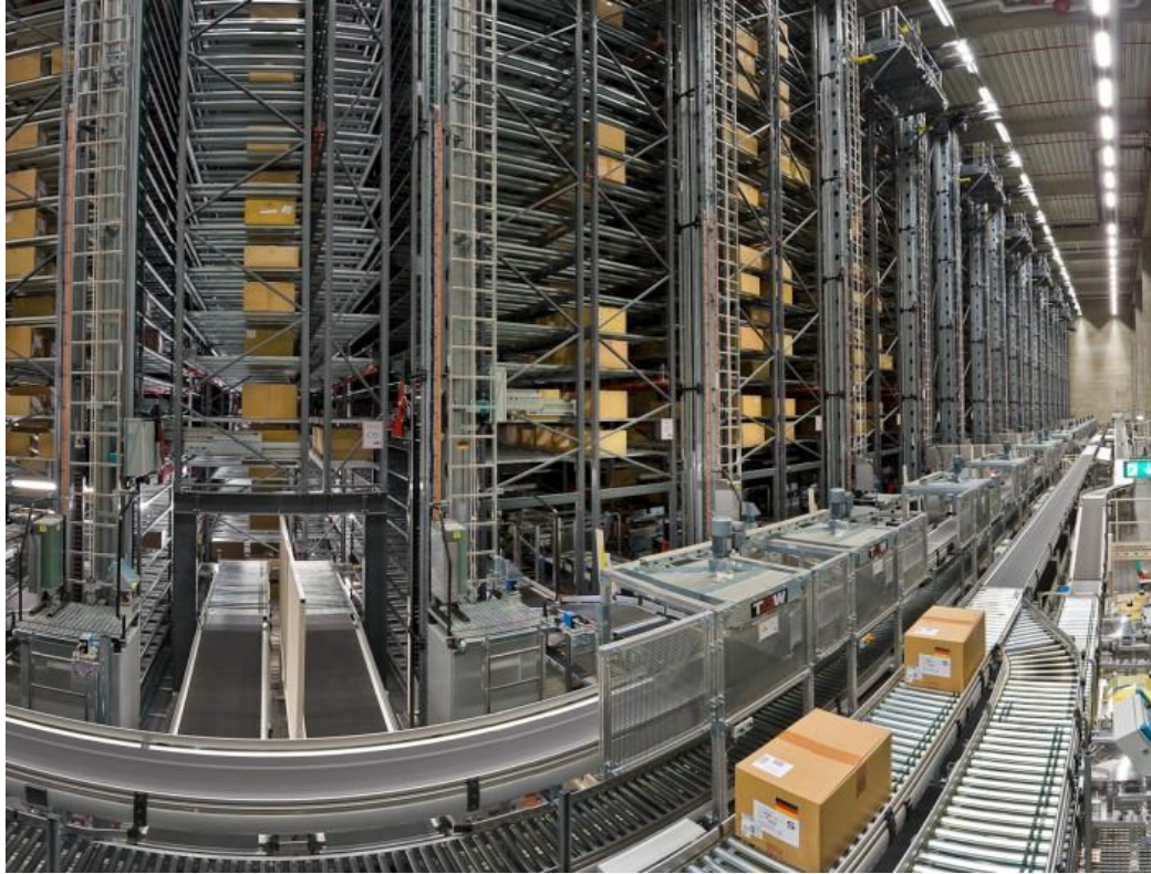
Рисунок 1.8 – Автоматизированные складские системы
