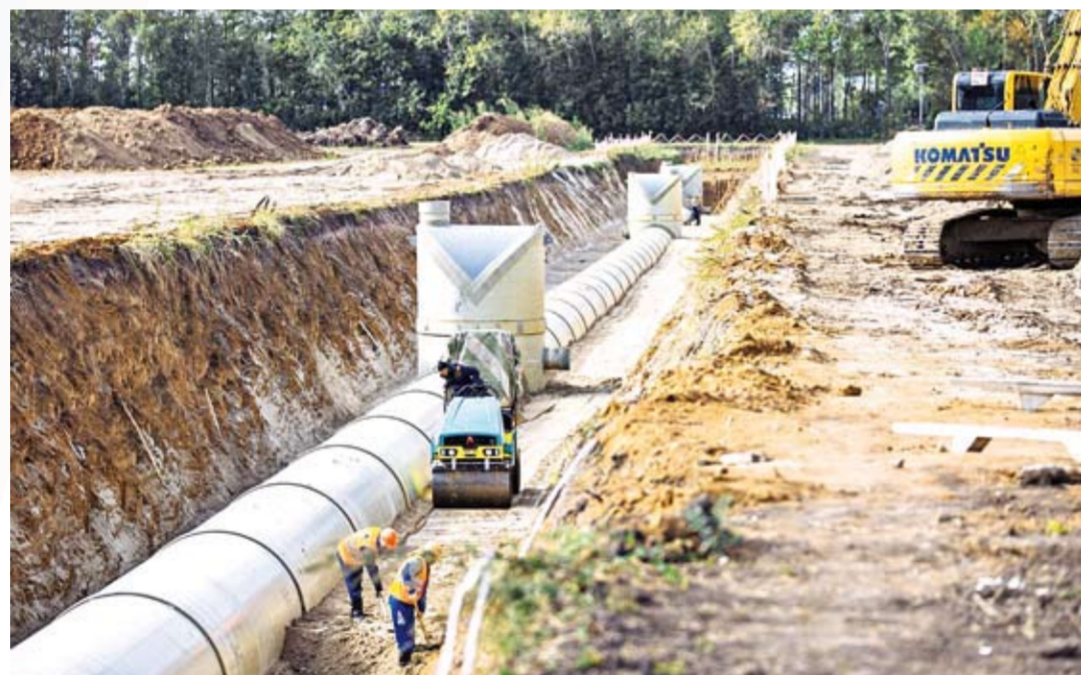
В промышленном парке «Рязанский» заканчиваются работы по прокладке инженерных коммуникаций
