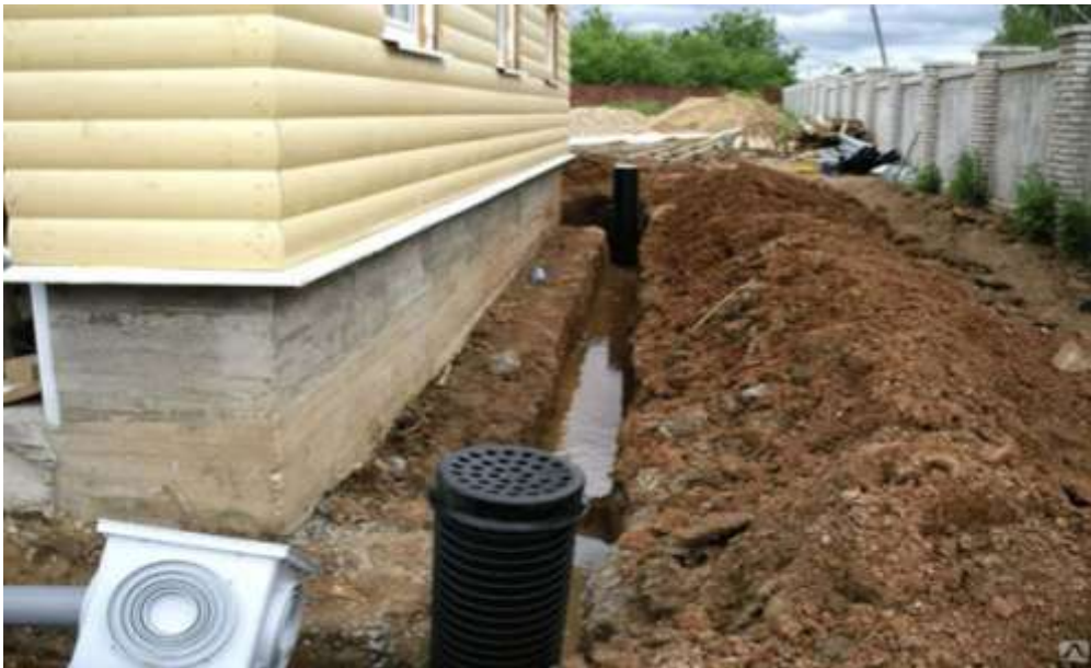
Рисунок 4 – Установка дренажных систем
