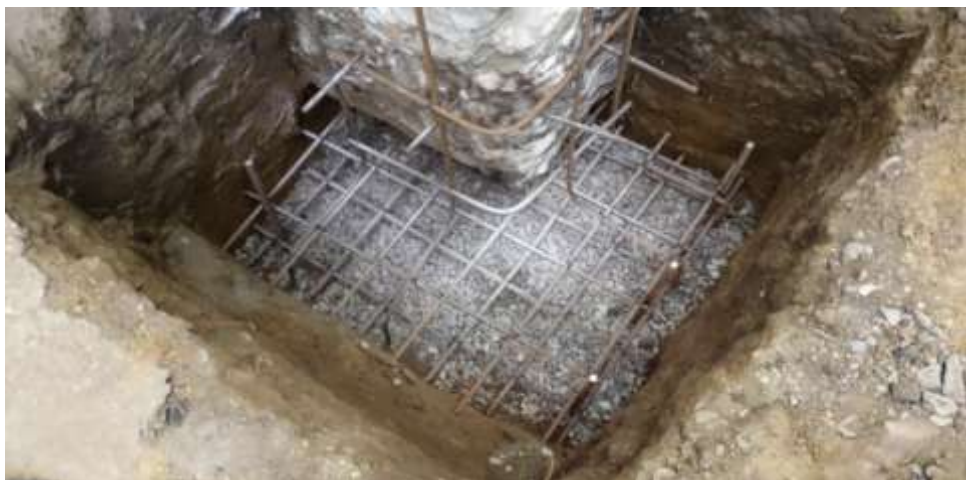
Рисунок 1 – Устранение дефектов фундаментов
