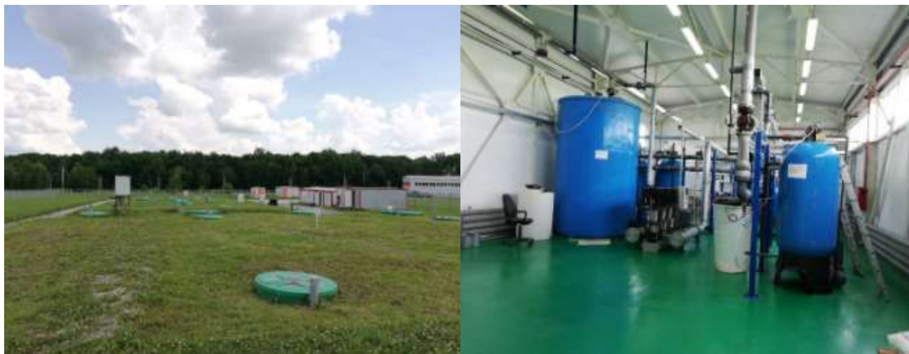
Рисунок 3 – Водоочистные сооружения предприятия
