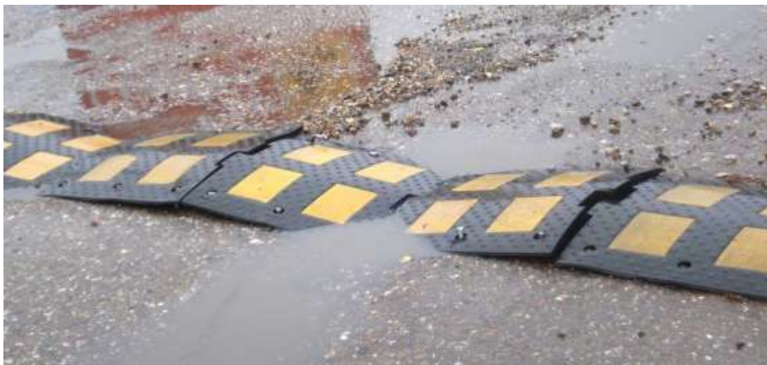
Рисунок 3 – Поломка искусственной неровности
