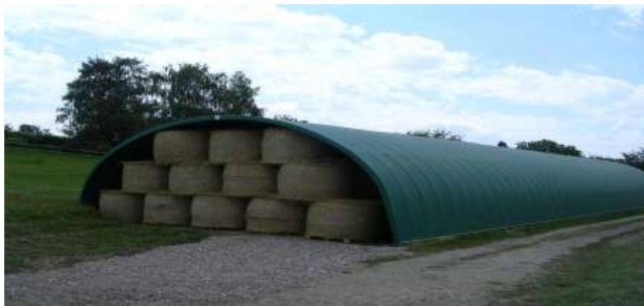
Рисунок 4 – Складирование рулонов сенажа под навесом
