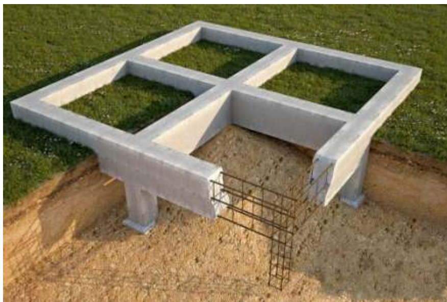
Рисунок 4 – Гибкий ленточный фундамент
