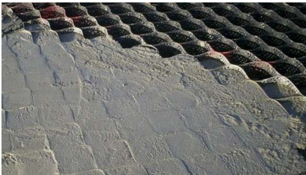
Рисунок 2 – Георешетка в бетонной заливке
