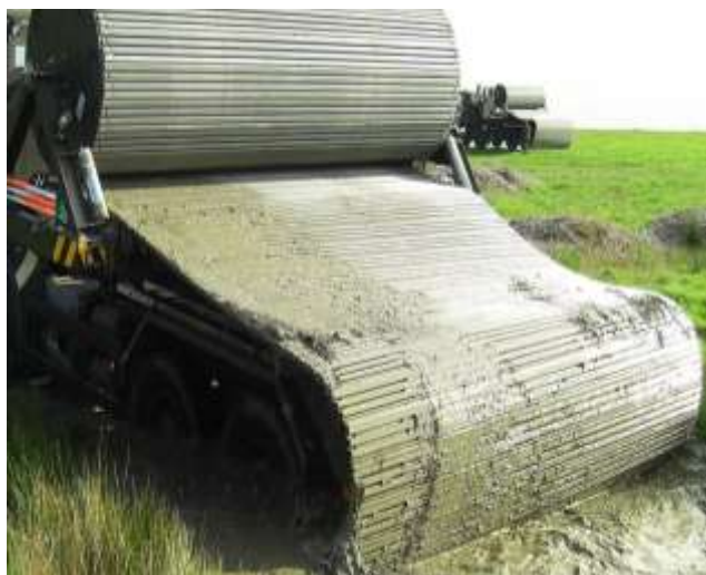
Рисунок 3 – Монтаж мобильного дорожного покрытия
