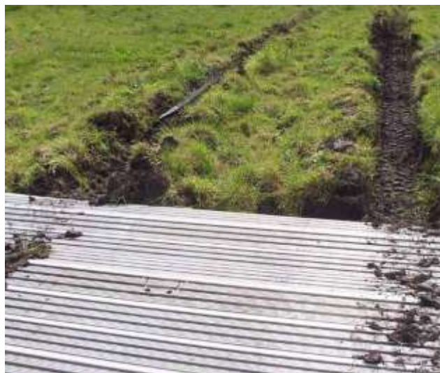
Рисунок 3 – Монтаж мобильного дорожного покрытия
