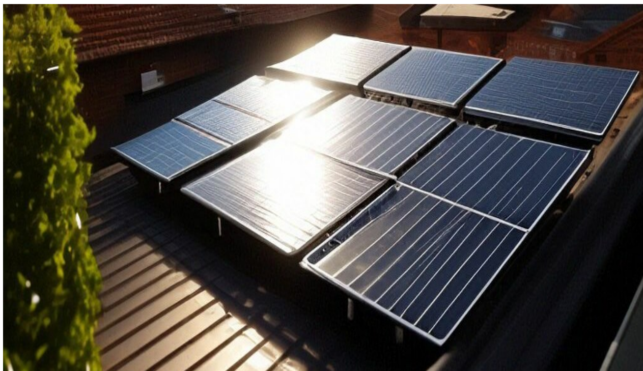
Рисунок 3 – Применение солнечных батарей на крыше помещения, предназначенного для хранения автодорожной техники
