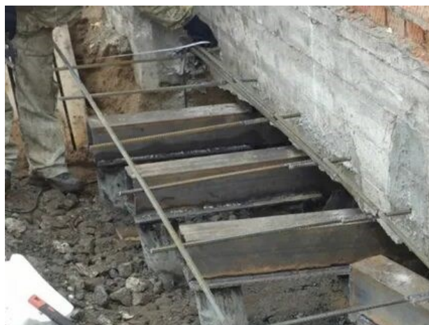
Рисунок 2 – Метод с использованием балочных элементов
