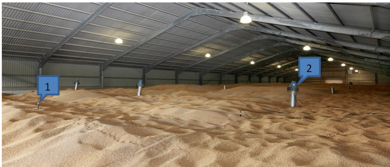
1 – вентиляторы; 2 – датчики температуры Рисунок 1 – Размещение зерна в виде насыпи
