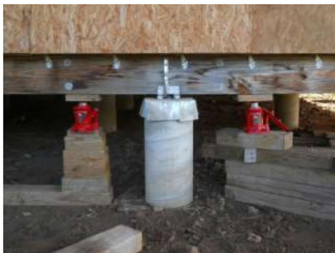
Рисунок 1 – Метод жесткой плиты
