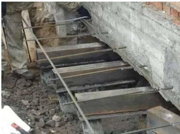
Рисунок 2 – Метод с использованием балочных элементов
