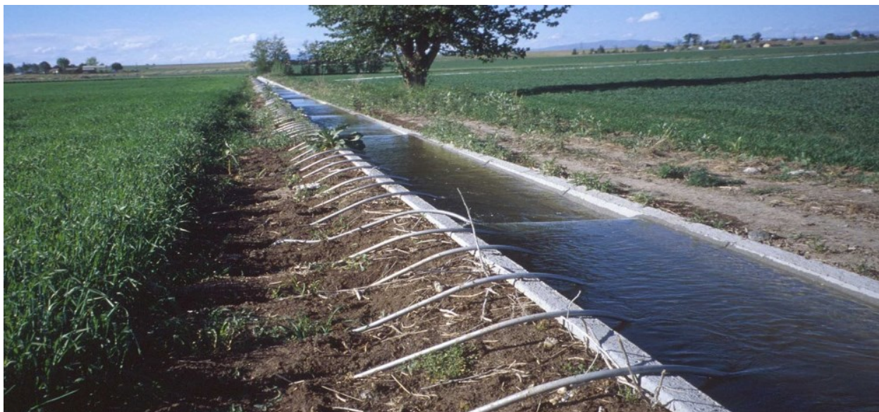
Рисунок 2 – Линейная изоляция оросительных каналов (пример бетонных покрытий)
