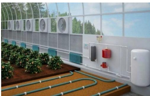
Рисунок 2 – Общий вид контура и системы обогрева Голландских теплиц.
