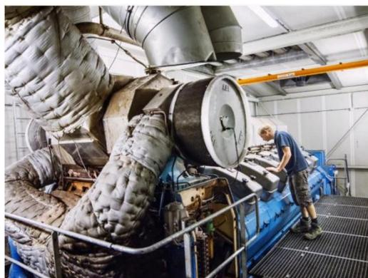
Рисунок 3 – Энергонезависимая технология биогаза с генератором, превращающий биогаз в электричество для освещения агрофермы, а выделяющиеся тепло и углекислый газ на обогрев теплиц и ускорение роста растений
