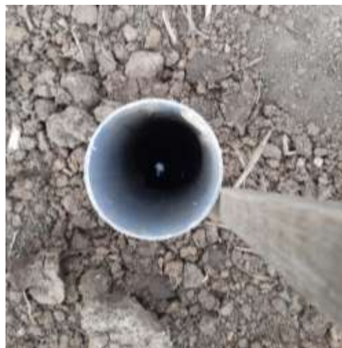
Рисунки 2 – Бурение и обустройство наблюдательных скважин на участке стационарных наблюдений (июнь 2023 года)
