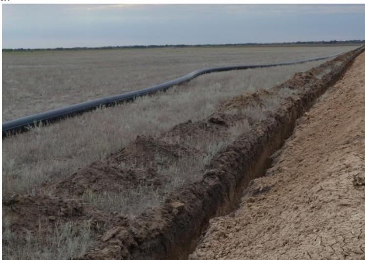
Рисунок 2 – Укладка полиэтиленового трубопровода оросительной системы в траншею
