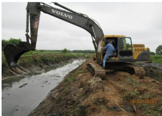
Рисунок 4 – Расчистка магистрального канала 2-ГД ПК12 «Кормовые угодья – Тинки»
