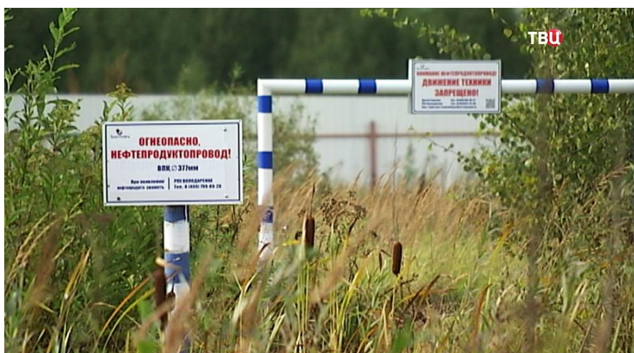
Рисунок 1 – Информационный знак охранной зоны магистрального нефтепродуктопровода
