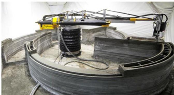
Рисунок 2 – Процесс печати конструкции дома с помощью 3D-принтера ApisCor
