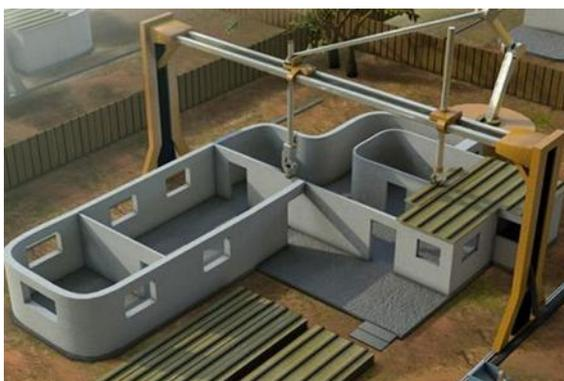
Рисунок 1 – Модель строительства 3D-принтером
