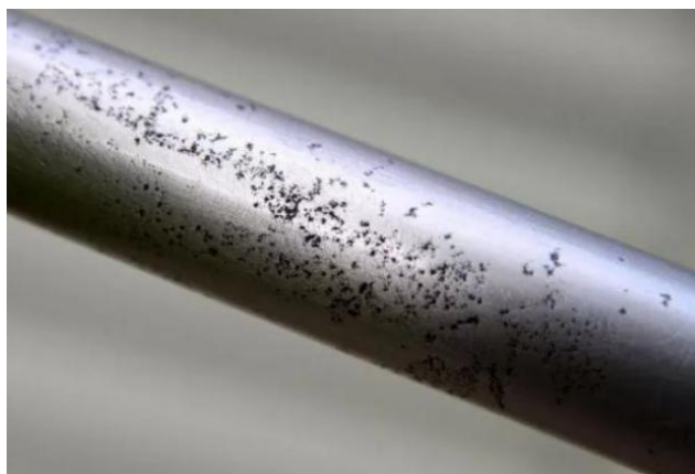
Рисунок 2 – Питтинговая (точечная) коррозия
