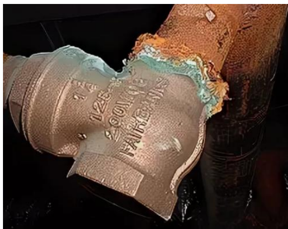
Рисунок 4 – Гальваническая коррозия металлов
