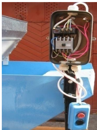
Рисунок 2 – Общий вид элементов щита управления электрическим двигателем привода транспортера вывoda семян опытного образца машины МВС-1,0 выделения ядовитой спорыньи из зерна ржи по удельной массе в водном растворе соли
