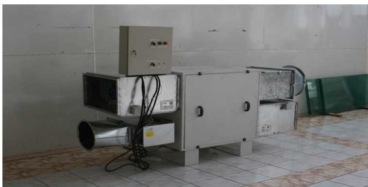
Рисунок 3– Рекуператор-теплообменник
