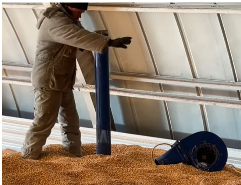
Рисунок 4 – Демонтаж аэратора зерна
