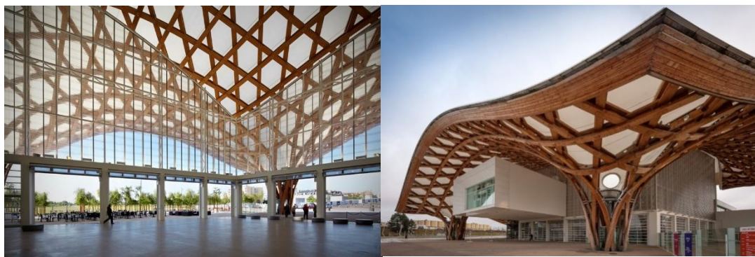
Рисунок 2 – Вид изнутри здания музея
