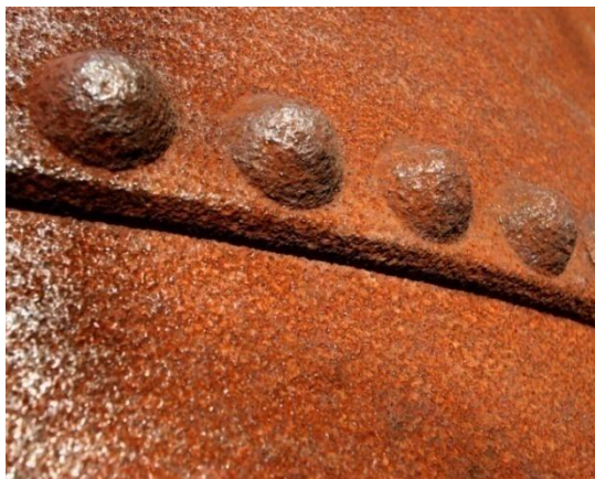
Рисунок 1 – Общая (равномерная) коррозия
