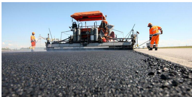
Рисунок 2 – Укладка асфальтированного бетона
