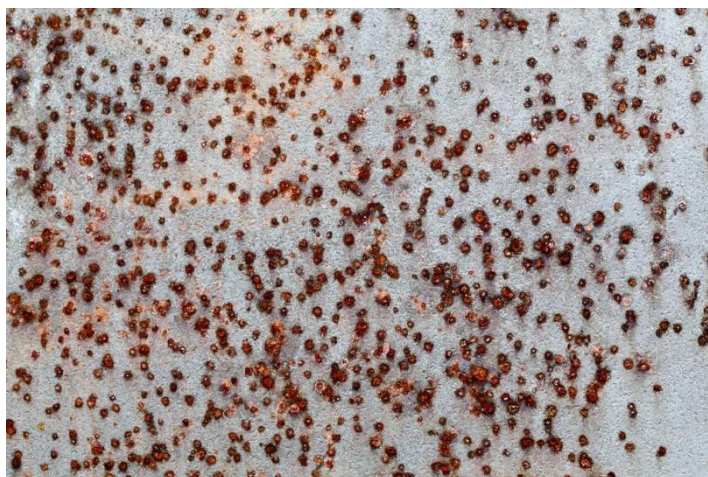
Рисунок 2 – Питтинговая (точечная) коррозия
