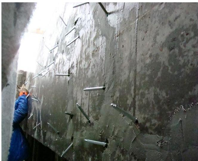
Рисунок 5 -Инъектирование трещин
