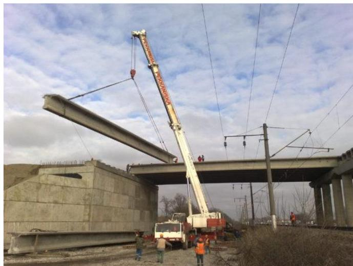
Рисунок 4 - Замена элементов автодорожного моста
