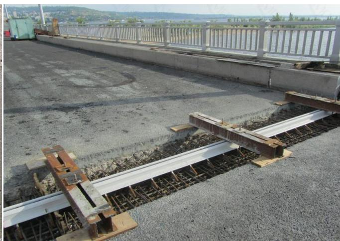
Рисунок 2 - Ремонт деформационных швов мостового сооружения
