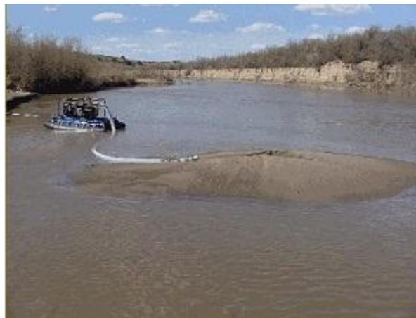
Рисунок 4 – Миниземснаряд для очистки и благоустройства водоемов
