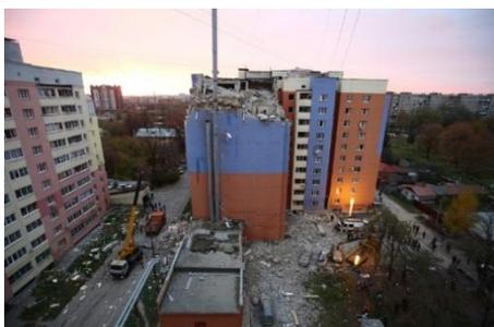
Рисунок 1 – Последствия взрыва газа в квартире, г. Рязань 2016 год
