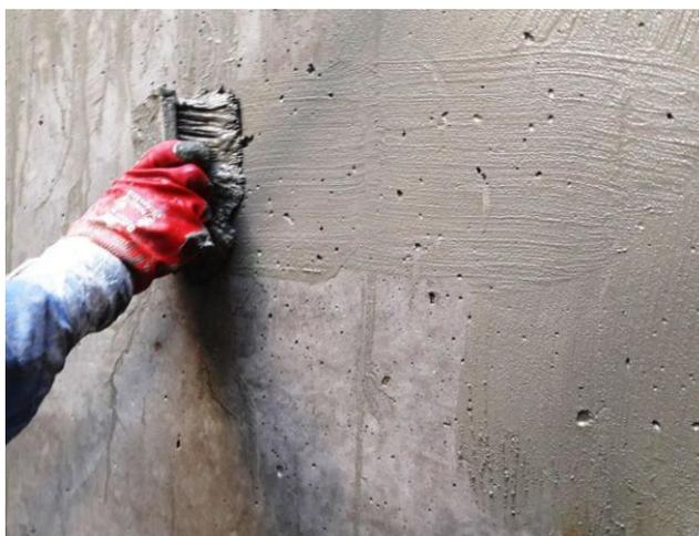
Рисунок 1 - Гидрофобная пропитка бетона
