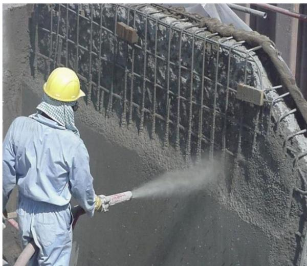
Рисунок 3 - Торкретирование разрушенной железобетонной конструкции
