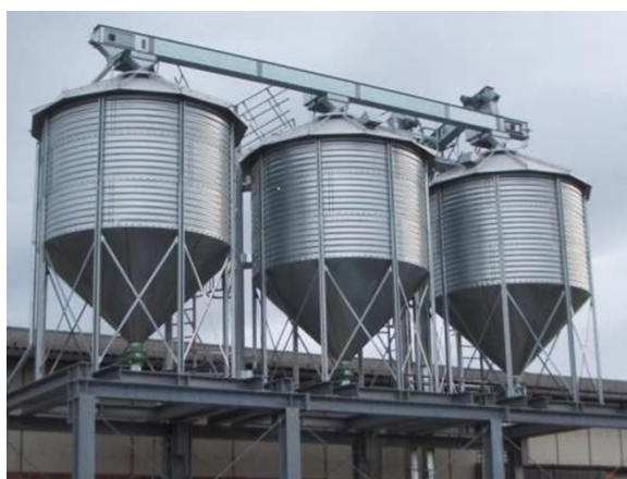
А) хранение в стандартных металлических силосах (элеваторах)
