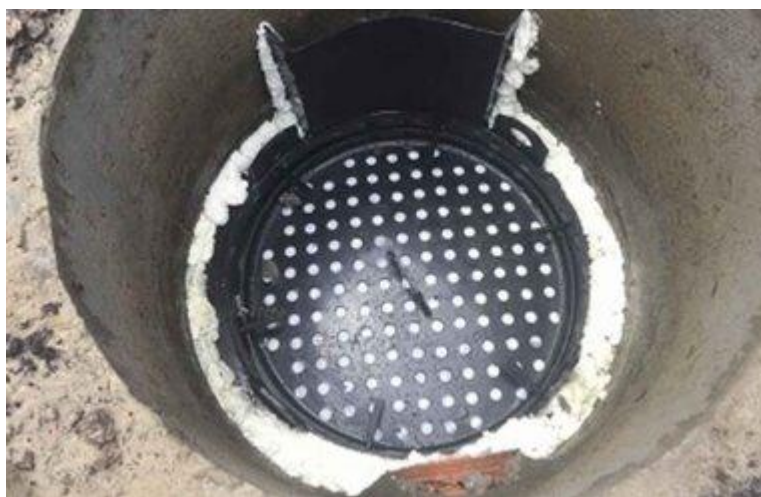
Рисунок 2 – Фильтрующий патрон, установленный в колодец
