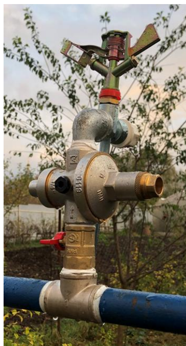
Рисунок 6 – Мембранный регулятор расхода воды
