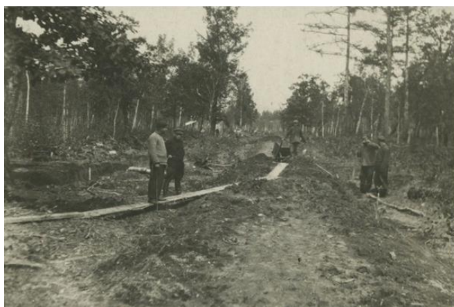
Рисунок 1 – Строительство дороги на осушительной системе, Полково, 1960-е гг.
