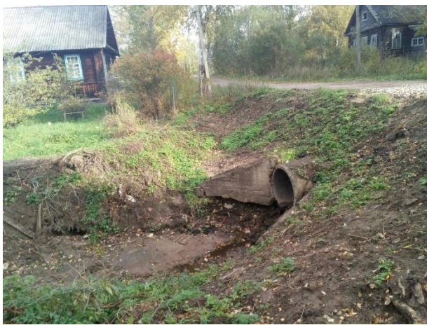
Рисунок 3 – Трубопереезд через нагорно-ловчий канал
