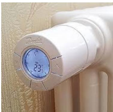
Рисунок 6 – Кран-терморегулятор нагрева теплоносителя в батарее
