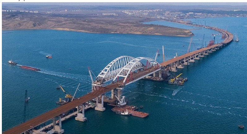
Рисунок 5 – Строящийся Крымский мост
