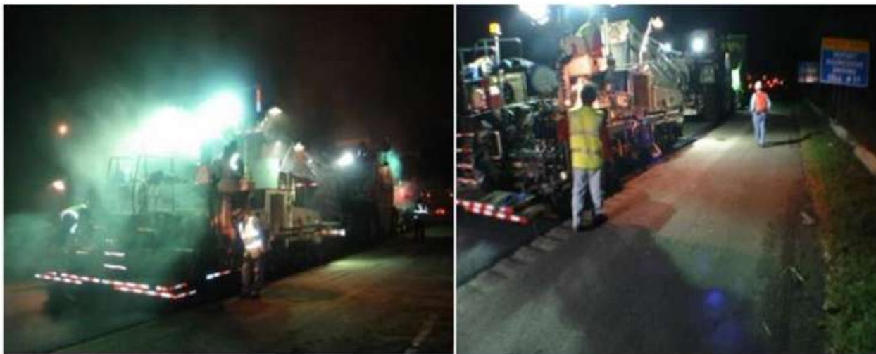
Рисунок 2 – Укладка асфальтобетона
