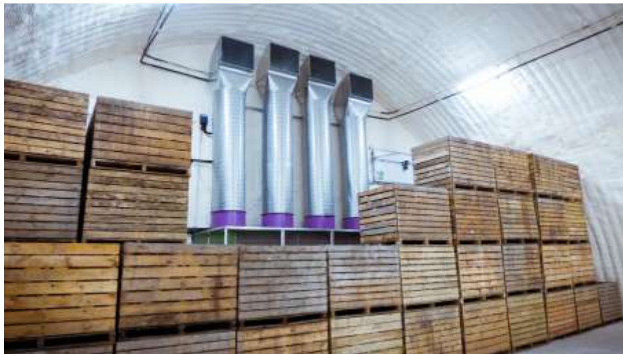
Рисунок 5 – Система микроклимата в овощехранилище «Магнит», работающая по принципу объемной вентиляции
