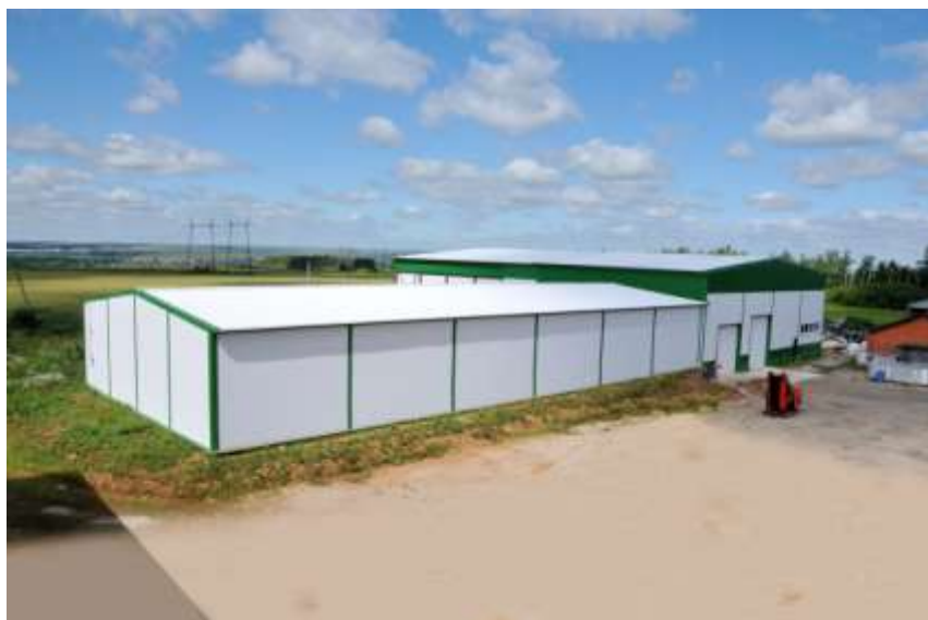
Рисунок 1 – Каркасное овощное хранилище с асфальтированной площадкой для хранения контейнеров
