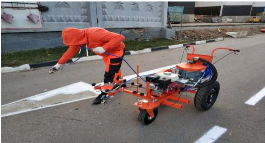
Рисунок 5 – Нанесение краски на дорожное полотно используя распылители
