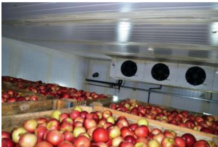
Рисунок 1 – Хранение сельскохозяйственной продукции в газомодифицированной среде
