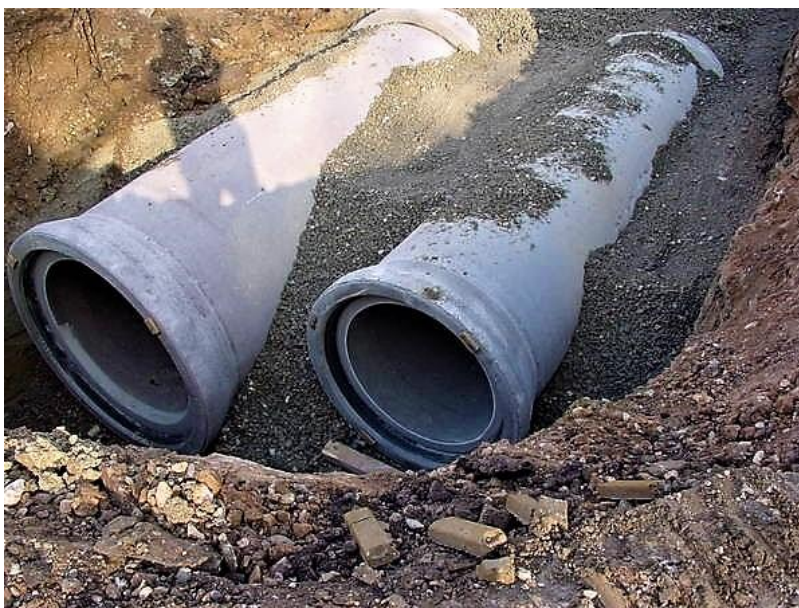
Рисунок 2 – Новое строительство отдельной канализационной системы.
