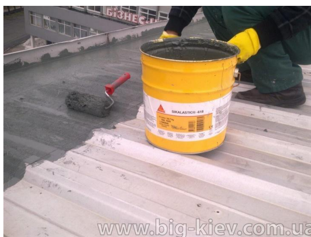
Рисунок 5 – Гидроизоляция полиуретановой жидкой мембраны.
