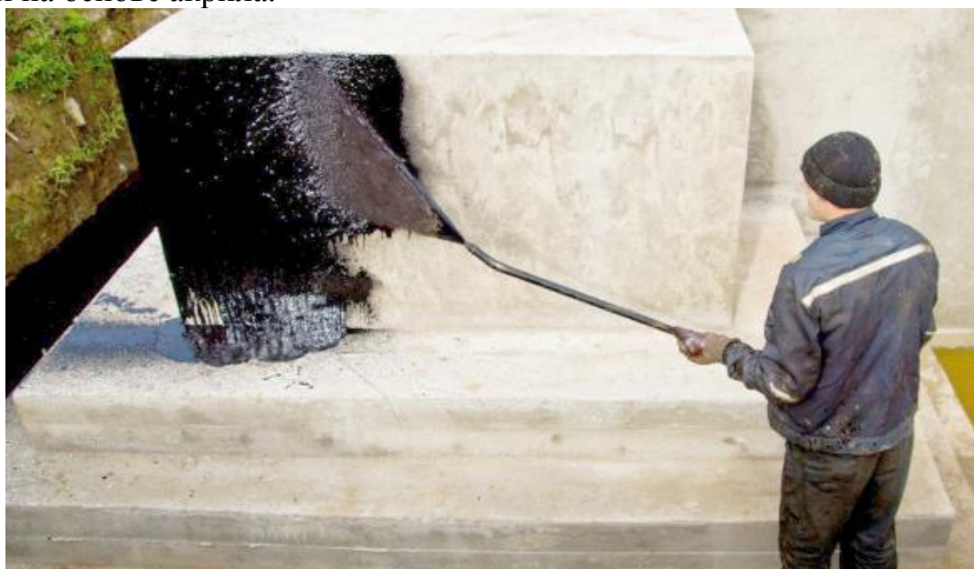
Рисунок 3 - Гидроизоляция битумного покрытия
