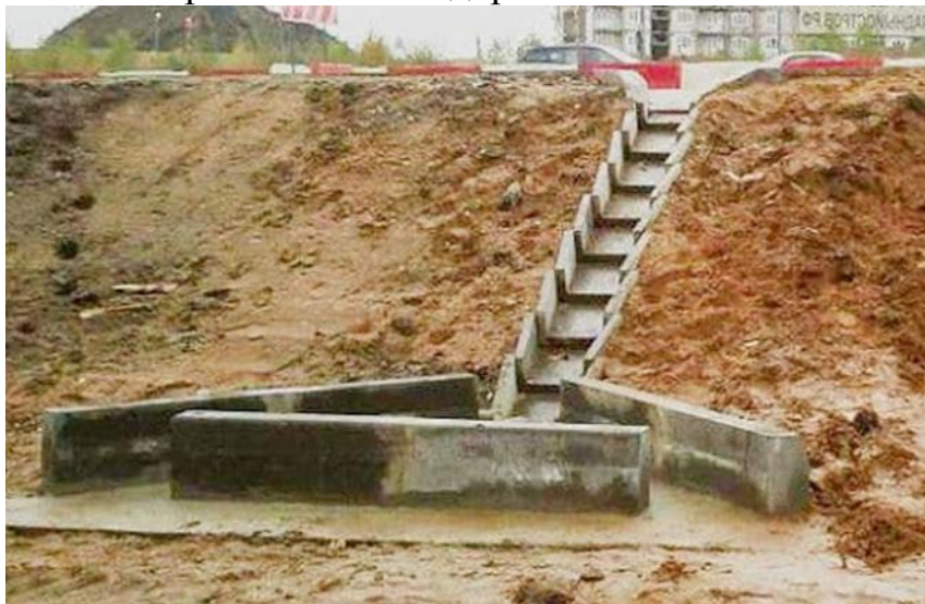
Рисунок 5 – Водоотводный канал, состоящий из водопропускных лотков
