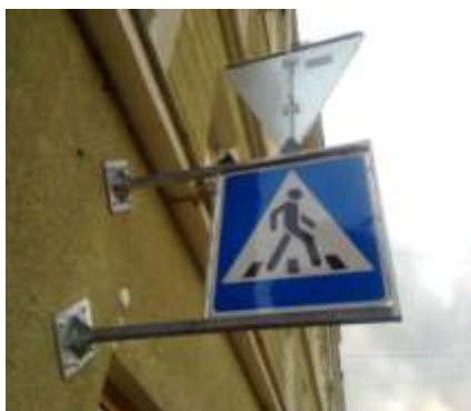
Рисунок 3 – Установка дорожного знака на стене здания
