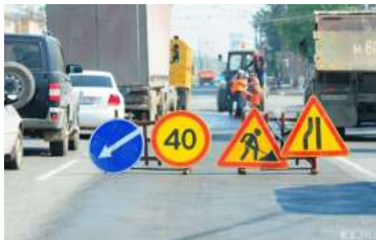
Рисунок 4 – Установка дорожных знаков на земле (временные дорожные знаки)
