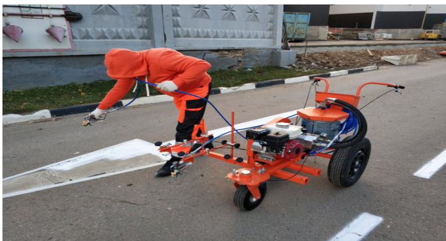
Рисунок 5 – Нанесение краски на дорожное полотно используя распылители
