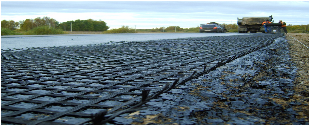
Рисунок 2 – Установка геосетки
