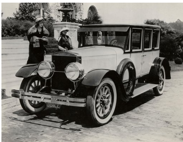
Рисунок 3 – 1925г. Doble E Sedan, Эта модель проходила без дозаправки водяного бака 1500 миль (2400 км) и развивала скорость 144 км/ч
