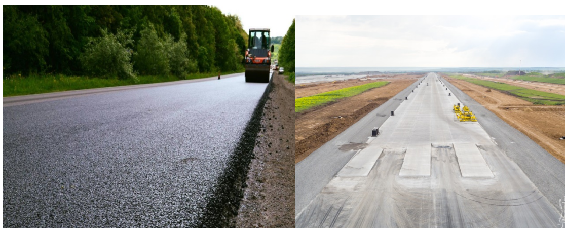
Рисунок 4 – Асфальтобетонное и цементобетонное покрытие
