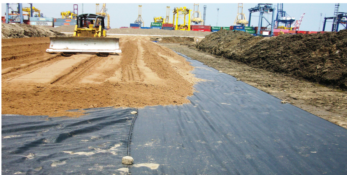
Рисунок 3 – Установка геотекстиля
