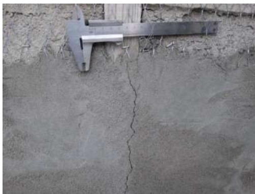
Рисунок 2 – Штукатурный раствор нанесен на металлическую штукатурную сетку
