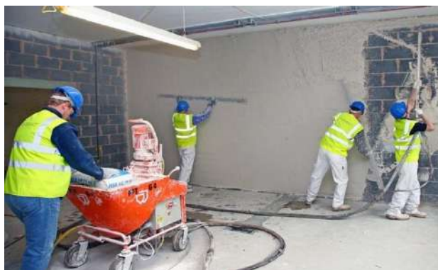
Рисунок 5 – Машина для механизированного нанесения штукатурки
