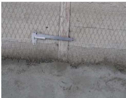
Рисунок 1 – Штукатурный раствор нанесен на стеклотканевую сетку с применением картушного пистолета
