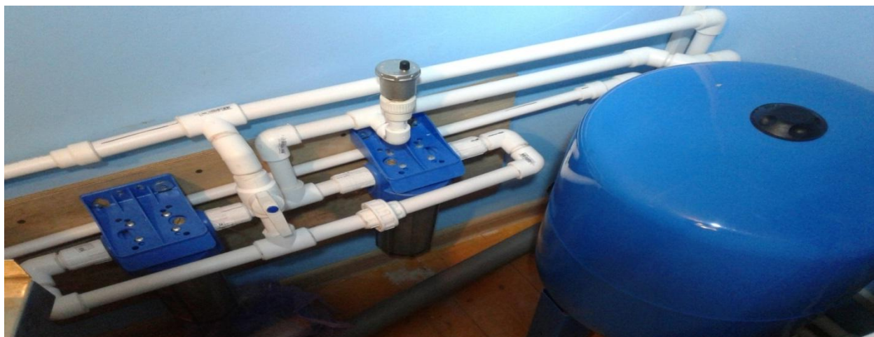
Рисунок 2 – Разводка труб водопровода и бак – накопитель для хранения запаса воды
