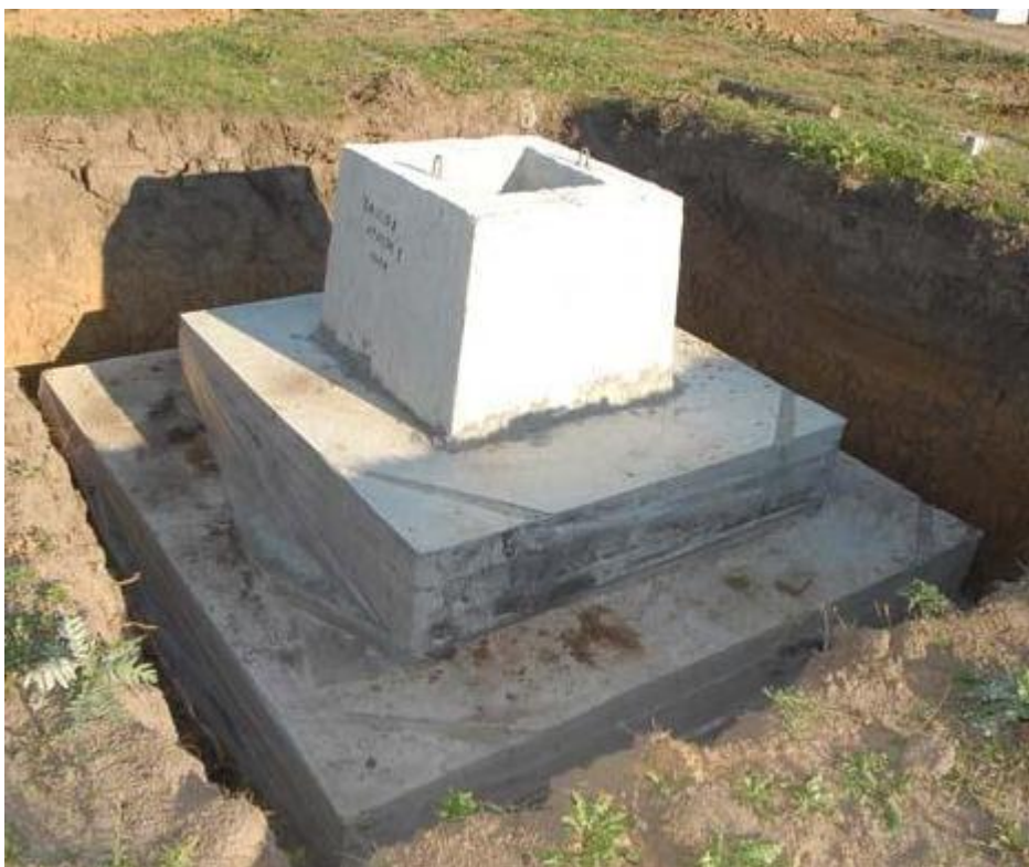
Рисунок 3.6 – Отдельно стоящие фундаменты под железобетонные колонны
