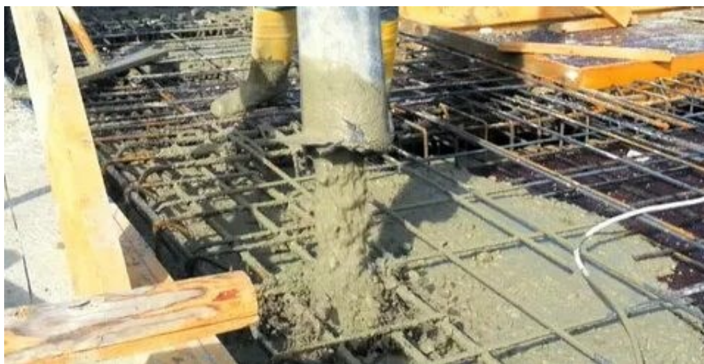
Рисунок 3 – Заливка бетона
